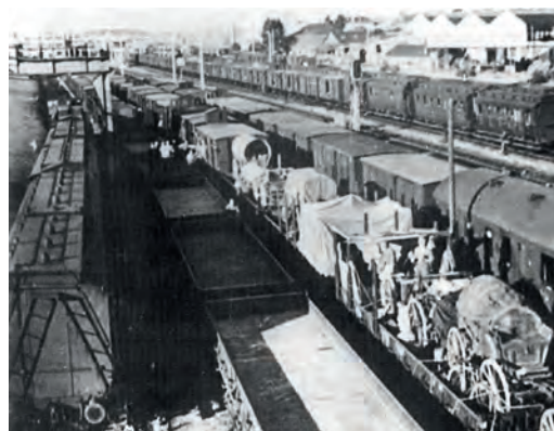
Zdjęcie stacji kolejowej na terenie Okręgu Polesie Armii Krajowej, wykonane przez wywiad AK. A photo of the railway station in the Polesie Home Army District, taken by the Home Army Intelligence.
