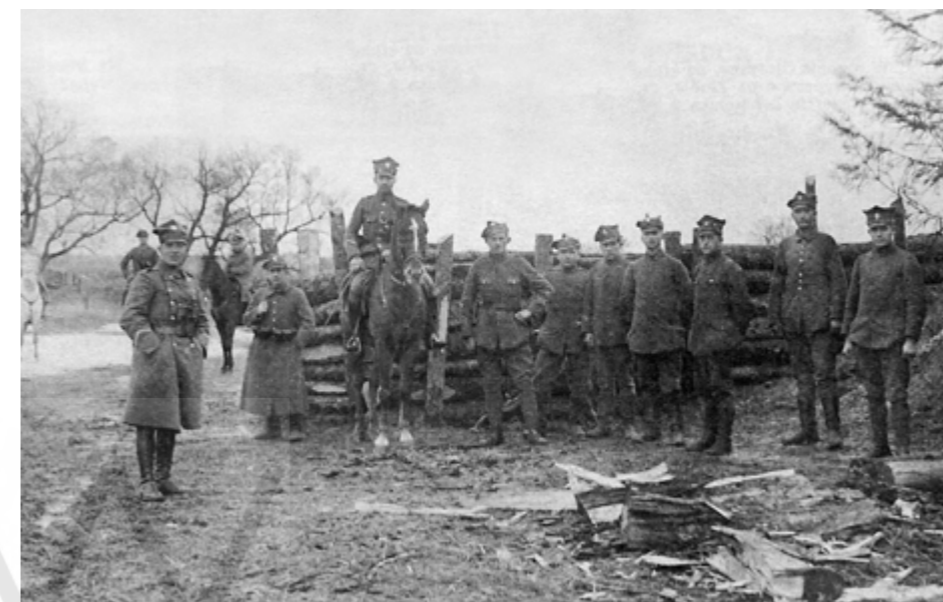
Budowa schronów bojowych nad Ptyczą w rejonie Bobrujska, marzec 1920 roku. The construction of bunkers by the Ptycza river, in the Babruysk region, March 1920.
