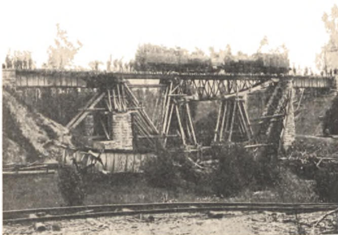
Próba obciążenia odbudowanego mostu przez saperów kolejowych w roku 1920
