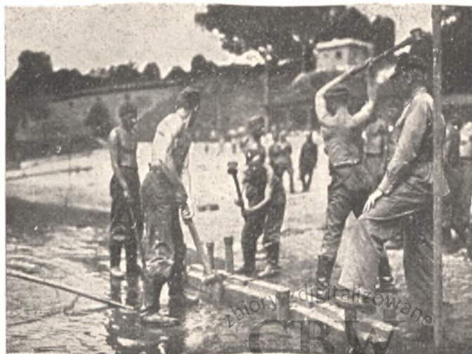
Zakładanie progu
