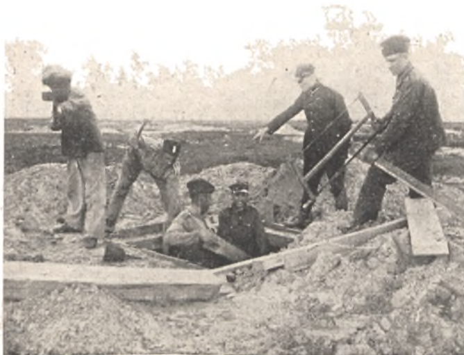
Budowa studni minerskiej
