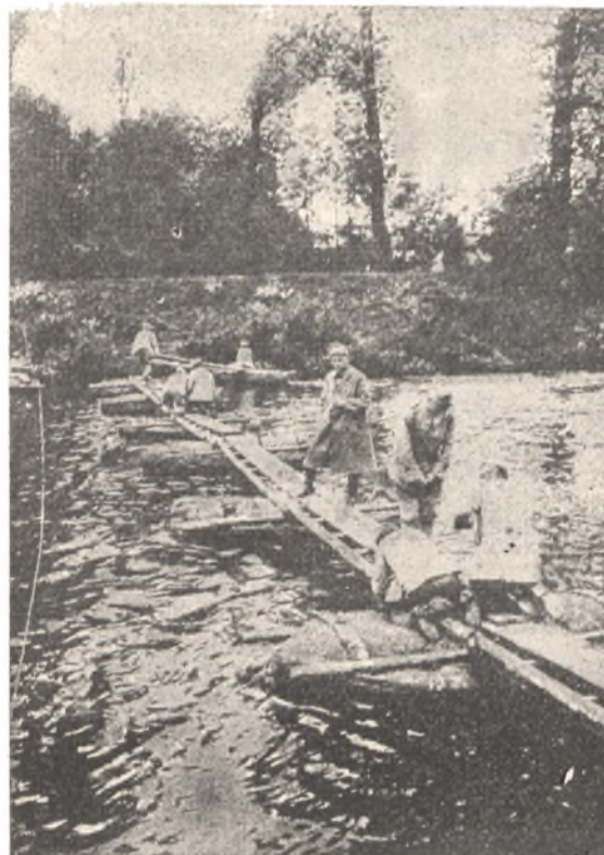
4 pułk inżynieryjny armii gen. Hallera — budowa kładki
