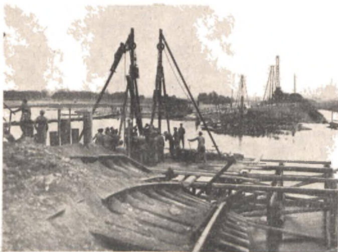
Odbudowa przez saperów kolejowych zniszczonego mostu
