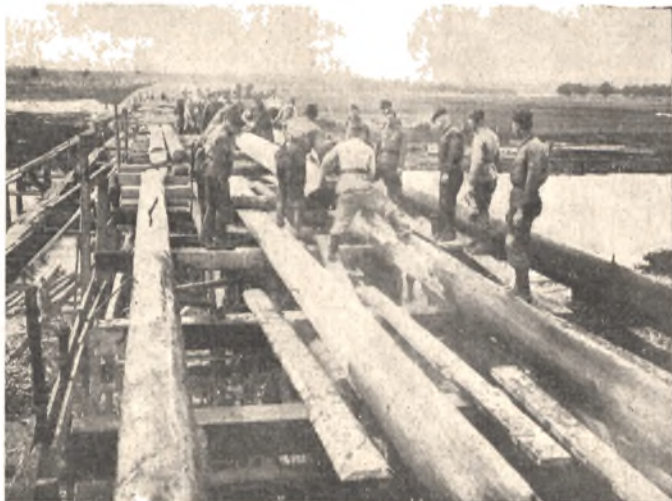
Budowa mostu na wschodnich rubieżach
