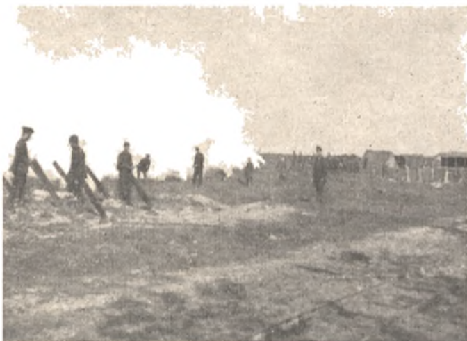
Budowa przeszkód przeciwczołgowych
