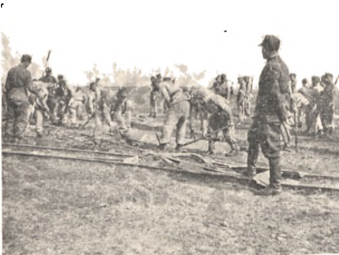
Budowa kolejki wąskotorowej
