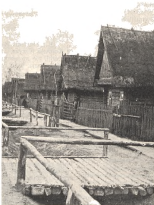
Niegdyś tonąca w błocie ulica wsi nadgranicznej na Polesiu, dziś zupełnie zmieniła swój wygląd dzięki przekopanym rowom i pobudowanym mostkom. Przykład dobrego wpływu miejscowego dowódcy strażnicy
