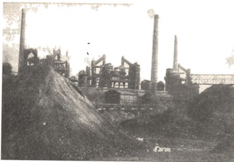
Hałdy rudy żelaznej i wielkie piece w „Hucie Pokoju“ w Nowym Bytomiu
