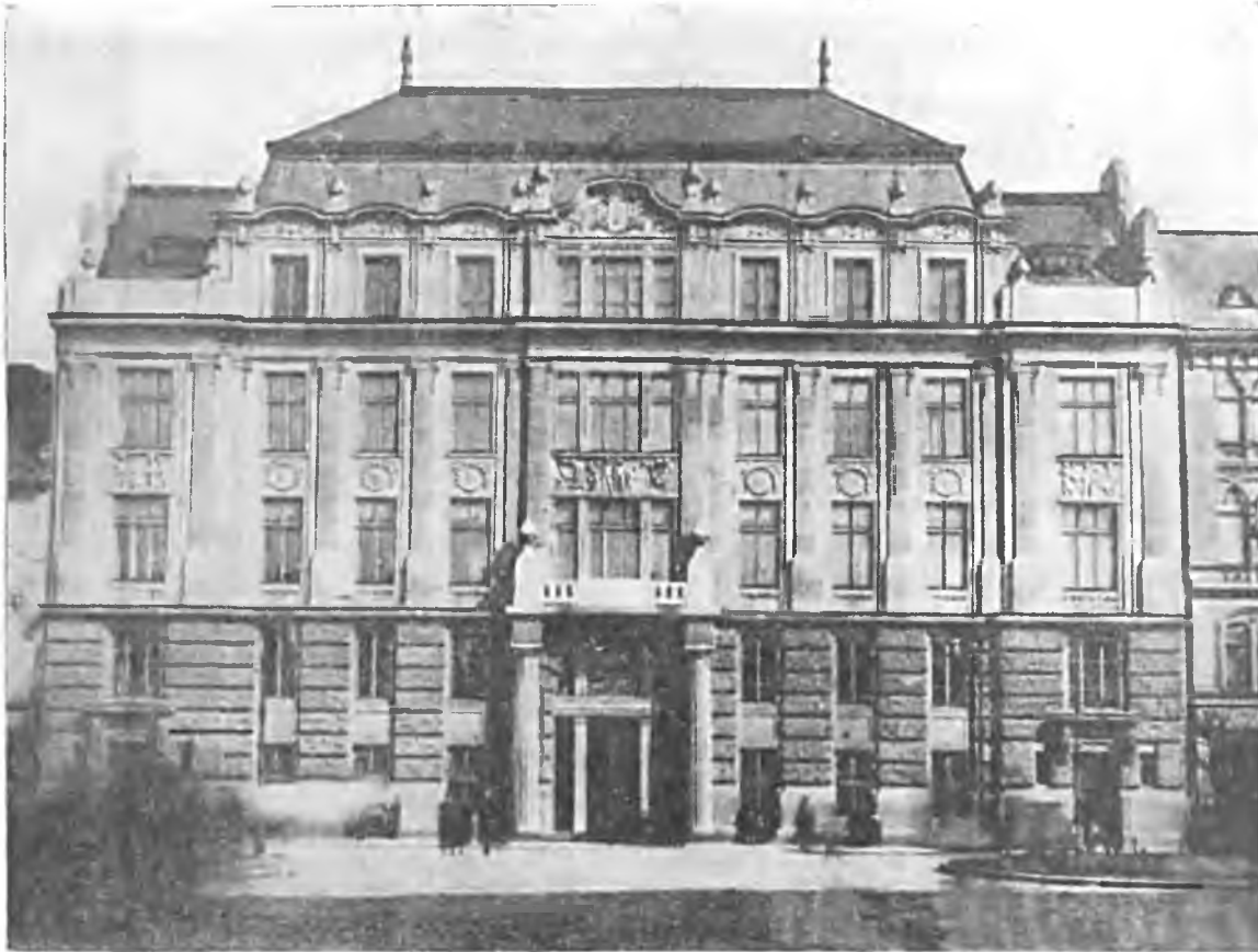
Gmach Izby Handlowej i Przemysłowej we Lwowie.
