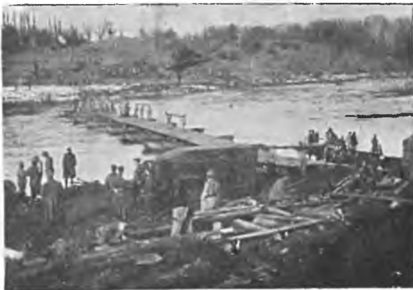
26 p. p. — Budowa mostu na Słuczy w 1920 r.
