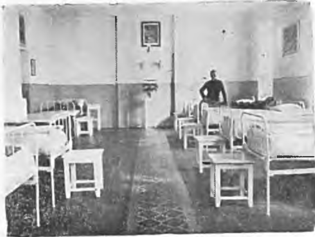
Izba chorych 6 dak. — Stanisławów.
