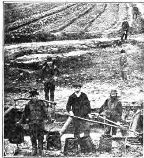
Borysław. Las wień drewnianych stojących nad szymbami naftowemi, z których wydobywa się ropa naftowa (na lewo) i „łapacze” nafty, zbierający ropę naftową, spływającą na powierzchni wody każdego niemal strumyka borysławskiego (na prawo).
