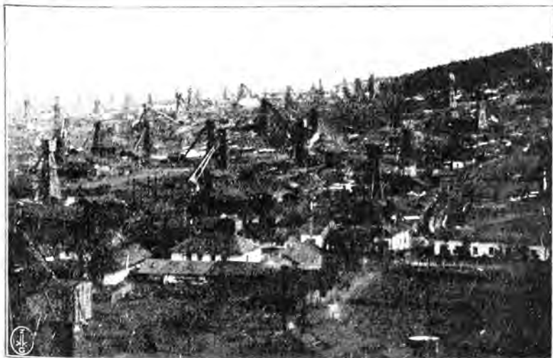
Borysław. Las wień drewnianych stojących nad szymbami naftowemi, z których wydobywa się ropa naftowa (na lewo) i „łapacze” nafty, zbierający ropę naftową, spływającą na powierzchni wody każdego niemal strumyka borysławskiego (na prawo).
