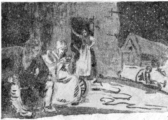
W obejściu odpoczywali ludzie po ciężkiej pracy
