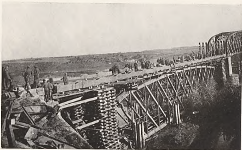
Odbudowa przez I. Bataljon kolejowy zburzonego mostu na Bugu pod Kamionką Strumiłową.
