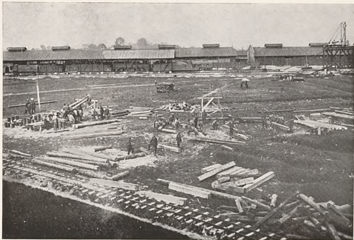
Roboty ciesielskie 1. pułku saperów kolejowych na poligonie ćwiczebnym w r. 1927.
