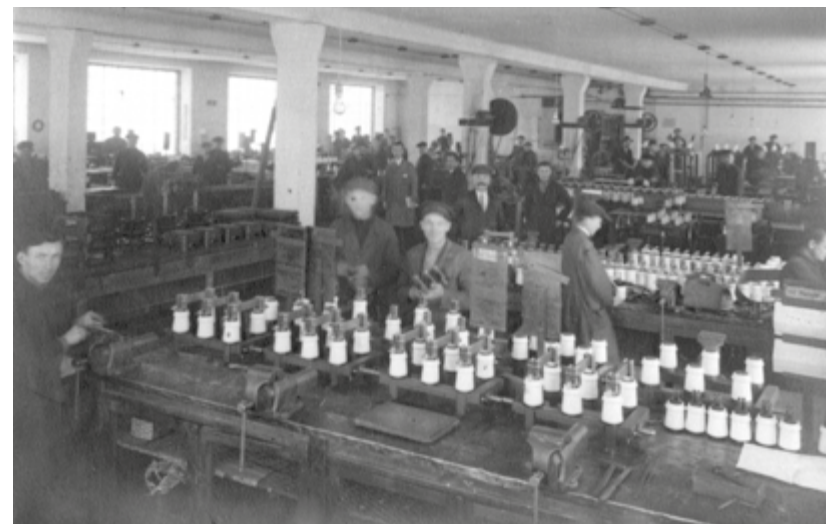
Hala montażowa aparatów wysokiego napięcia, lata 30. XX wieku.
