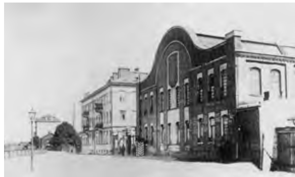
Hala główna Centralnych Warsztatów Samochodowych, dalej brama wjazdowa i budynek biurowy, połowa lat 20. XX wieku.
