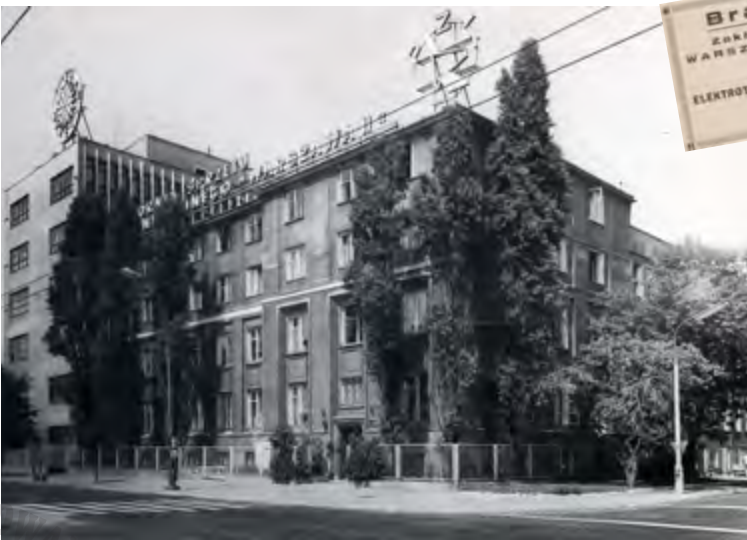
Dawna siedziba zarządu firmy Bracia Borkowscy Zakłady Elektrotechniczne SA przy ul. Grochowskiej 306/308, budynek podwyższony po wojnie, 1982 rok. WUOZ, sygn. N. /War. 684/III (fot. A. Stasiak).
