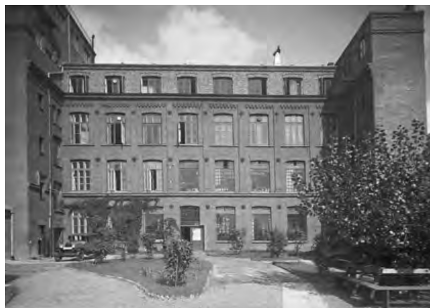
Budynek fabryki. Widok od strony dziedzińca, około 1927 roku.
