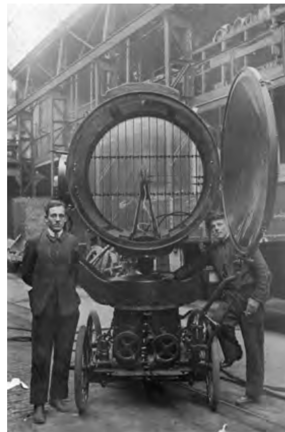
Hala główna Centralnych Warsztatów Samochodowych. Reflektor przeciwlotniczy w naprawie, około 1923-1925 roku.
