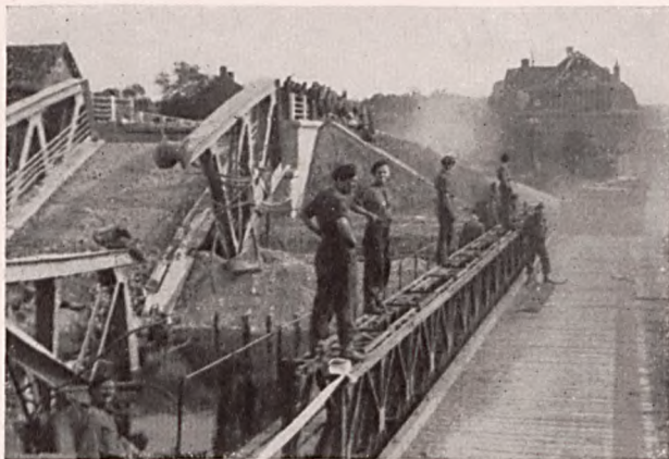
Przeprawa pod Abbeville The crossing near Abbeville
