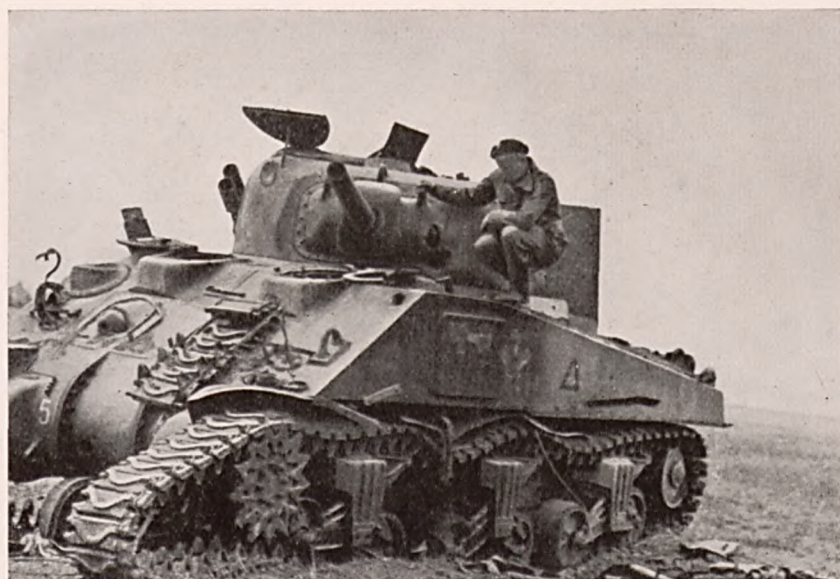
Czołg 1-go Szwadronu uszkodzony wybuchem miny i trafiony trzykrotnie z działa ppanc A tank of the 1st squadron damaged by a mine and hit three times by anti-tank gun
