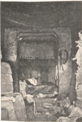
Wnętrze domu mieszkalnego
