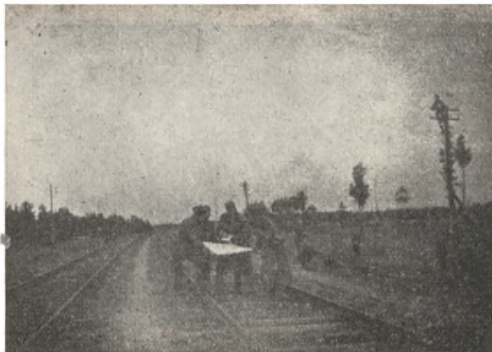
Odbudowa stałej linii telefonicznej Orany — Wilno w roku 1920, zniszczonej przez Litwinów. Przy pracy patrol kompanii telegraficznej 22 dywizji piechoty
